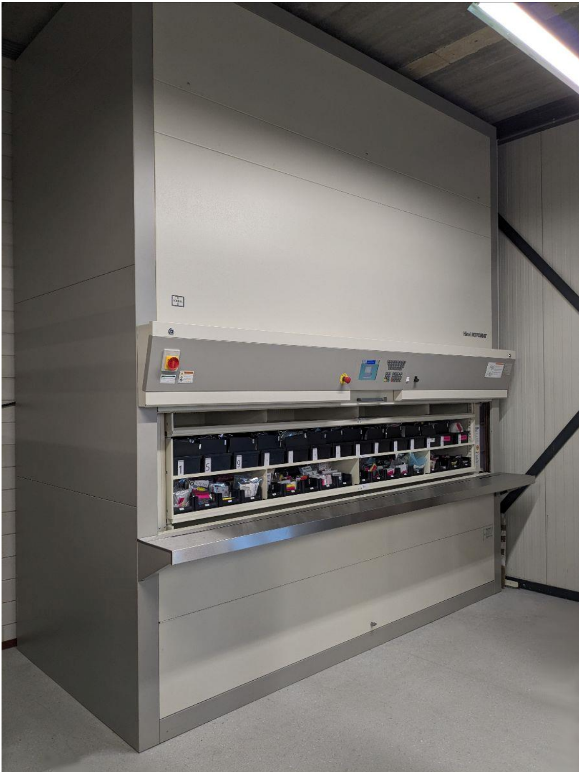
De nieuwe paternoster geïnstalleerd op de vloer
